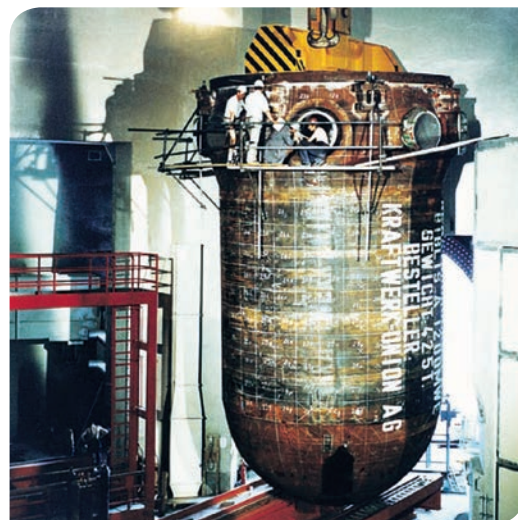
Abb. 7.08 Reaktordruckgefäß eines Druckwasserreaktors
